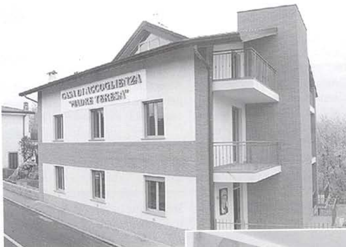
La casa di accoglienza ultimata
