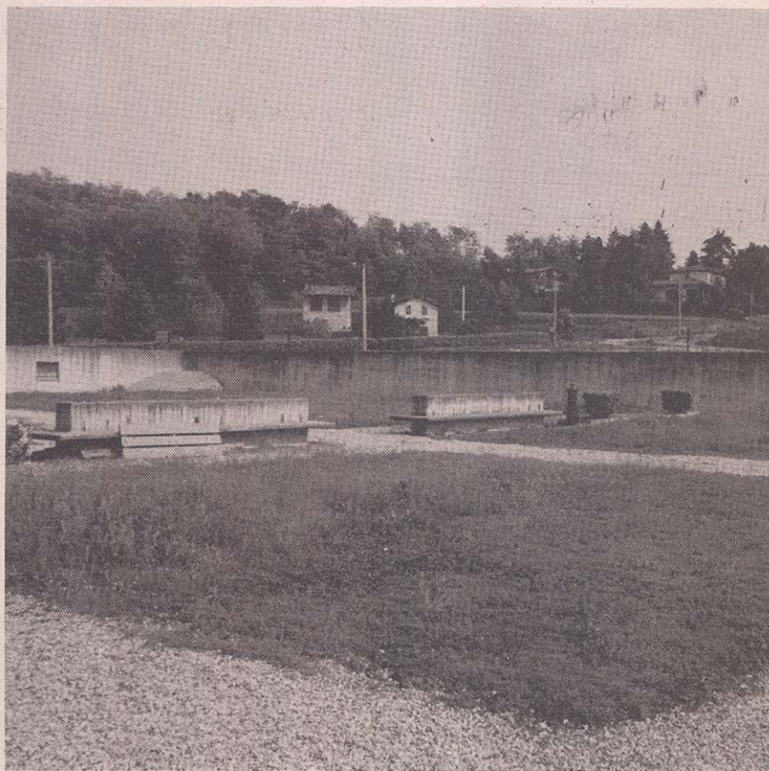
Cimitero: la zona dove sorgeranno i nuovi colombari
